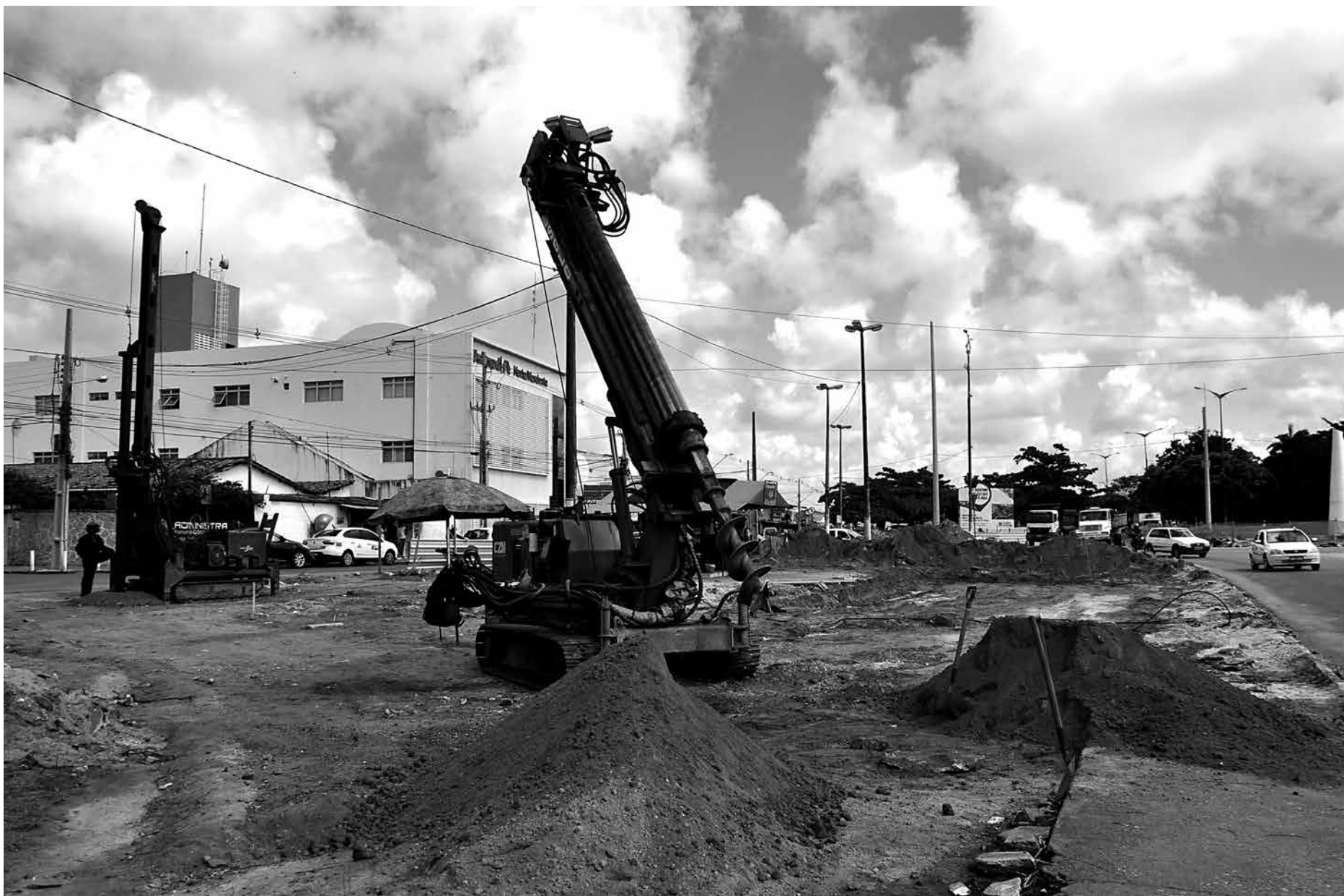
A construção do Trevo de Mangabeira, equipamento de mobilidade urbana, vai beneficiar diretamente mais de 250 mil moradores da região e cerca de 30 mil motoristas
